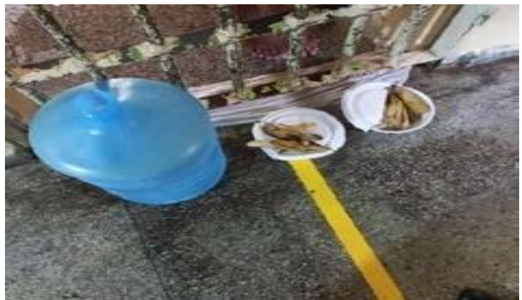
Imagem 34 - Chão de cela cheia de água no CDPM II.
