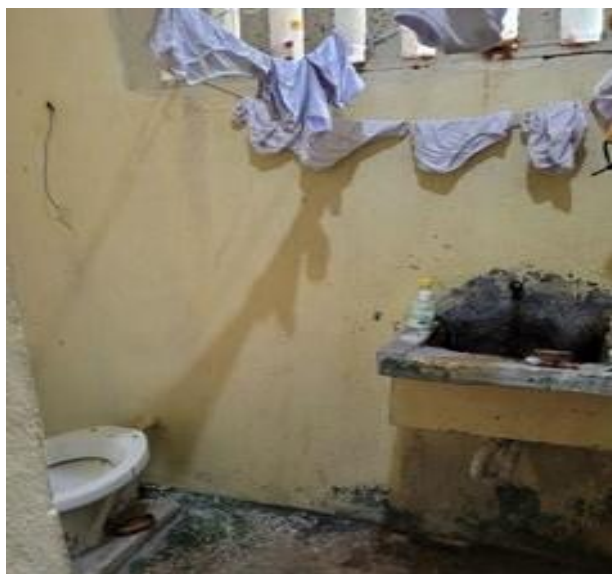
Imagem 9 - Banheiro com estrutura degradada, com infiltrações e paredes mofadas no CDPF.
