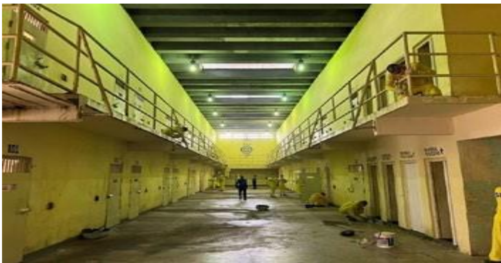
Imagem 37 Pavilhão em reforma durante a inspeção do CNJ.
