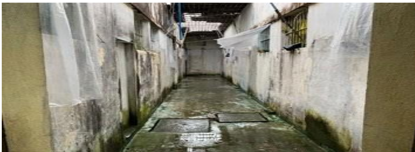
Imagem 8 - Corredor que dá acesso às celas no COMPAJ
